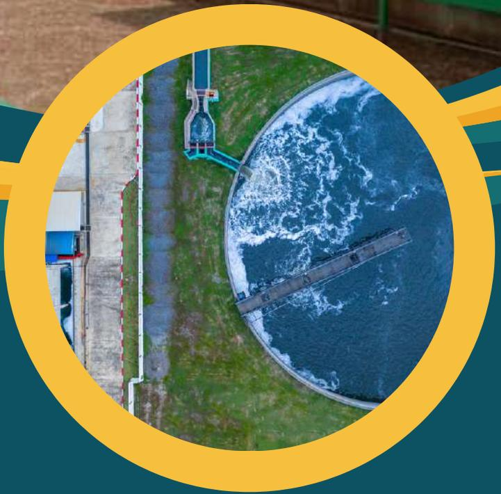
Air limbah dengan konsentrasi COD kurang dari 3000 mg/L dan rasio BOD antara 0,3–0,6 cocok untuk diolah menggunakan proses biologis aerobik. Proses ini bertujuan untuk mengurangi senyawa organik dalam air limbah dengan bantuan bakteri aerobik—yakni bakteri yang membutuhkan oksigen untuk menjalankan proses metabolismenya. Bakteri ini akan menguraikan senyawa organik menjadi  $\text{CO}_2$  (karbon dioksida) dan  $\text{H}_2\text{O}$  (air).
